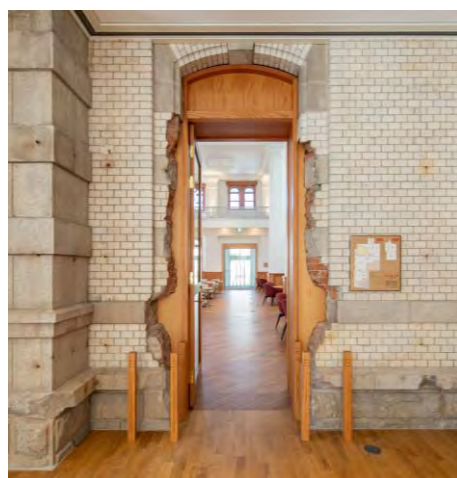
旧銀行棟の外壁とレンガ躯体
